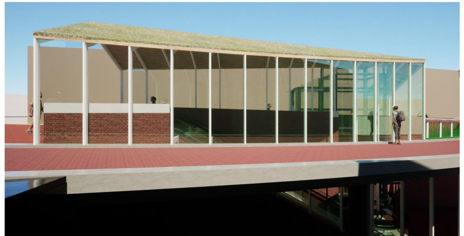
Overkapping Roltrappen Ankersmidplein Detail sedumdak op roltrap-overkapping
