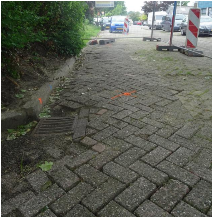
Afbeelding 6: Matig opgedrukte bestrating (boom nummer 36092)
