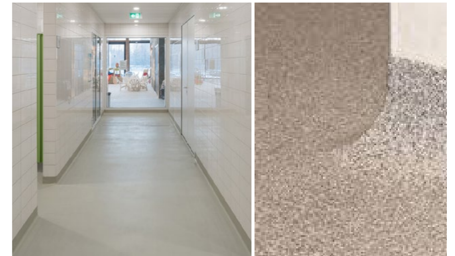
V4 Troffelvloer antislip met holplint. Grijs bij de gang en donker in de kleedkamers.
