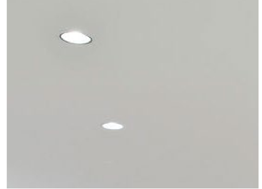
3 LAGERE PLAFONDS: Inbouw ronde downlights.
