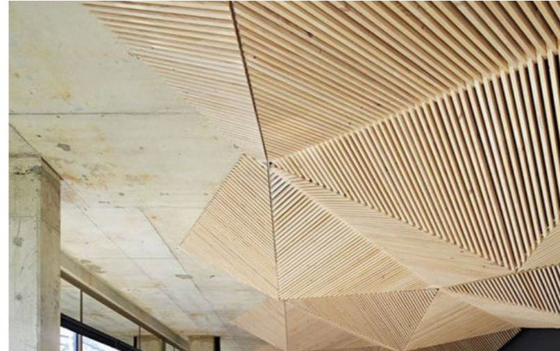
P1 Systeemplafond met houten latten Derako in driehoekige vlakken boven horeca, met hangende verlichting.
