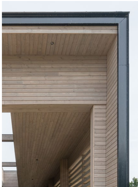
⑤ Ingang, houten latten.
