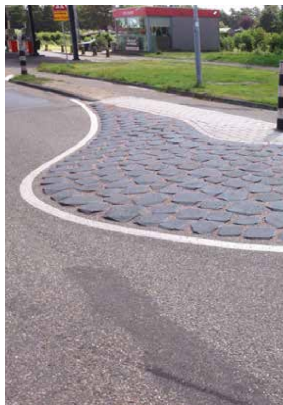
Bochtverbreding in taludblokken Basalton
