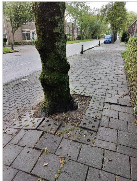
Afbeelding 2. Boom 13, zeer beperkte groeiplaats met wortelproblematiek.
